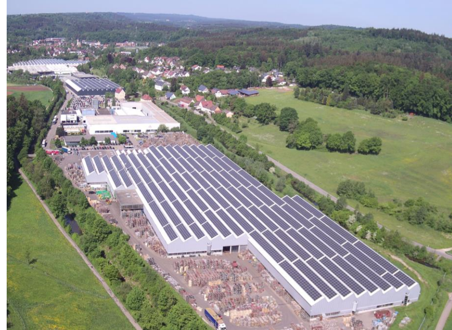
Bild: 13 MWp Dachanlage der Fa. Kessler + Co.GmbH+Co.KG in Abtsgmünd
