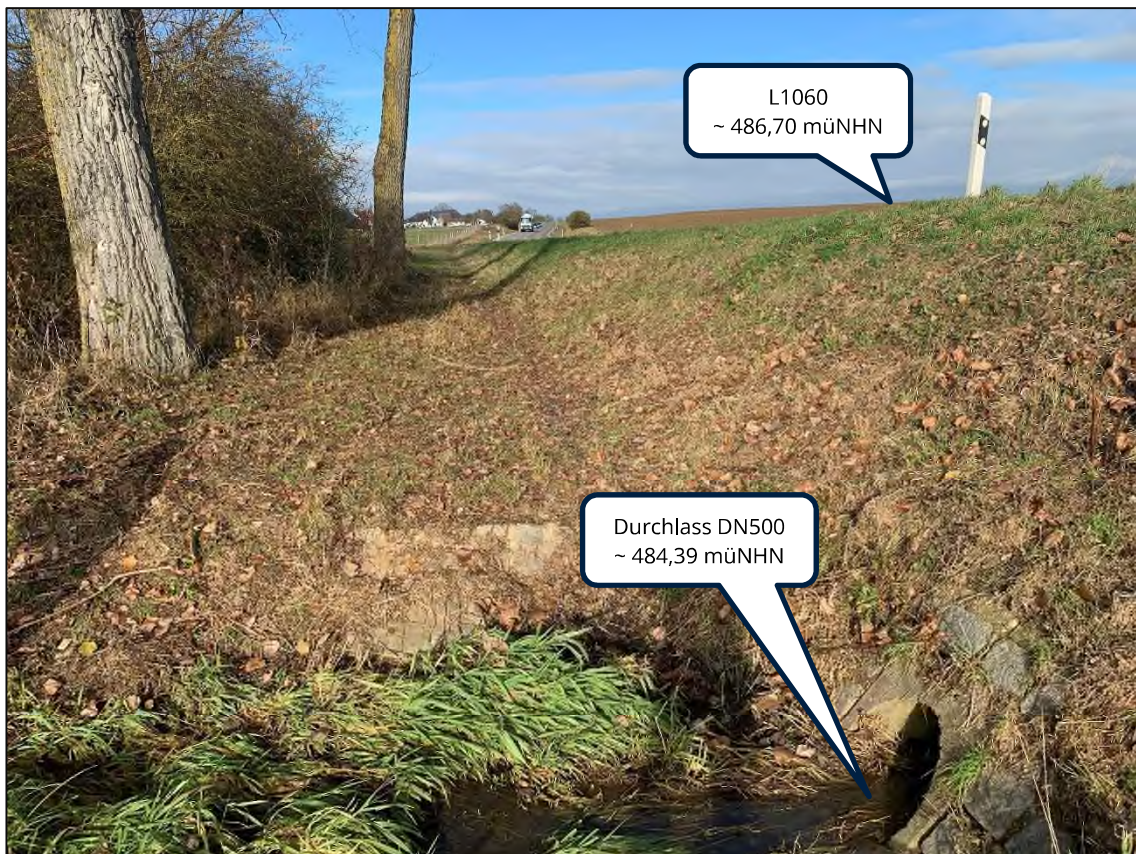
Abbildung 6: Durchlass des Scherweidgrabens (von links kommend) unter der L1060 (Blick nach Norden) (Quelle: BGS Wasser /U3/)
