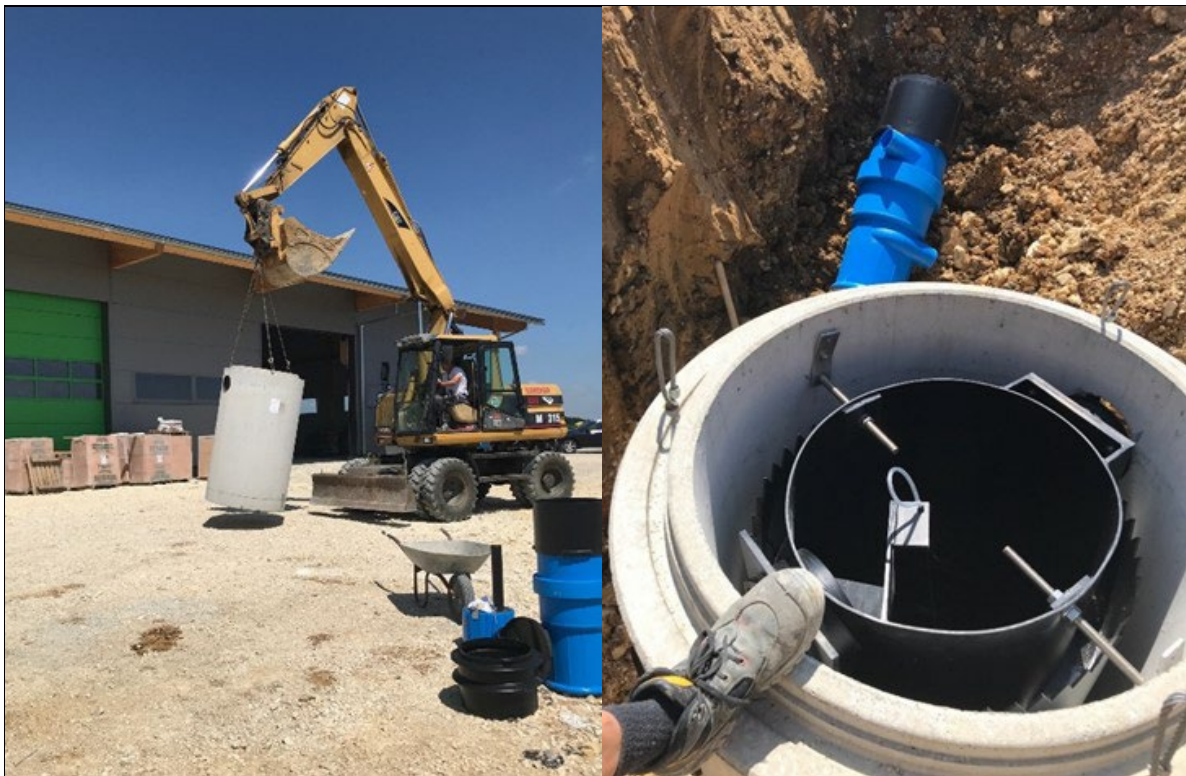
Bild 4-1: Einbau des Hydrosharks DN 1000
