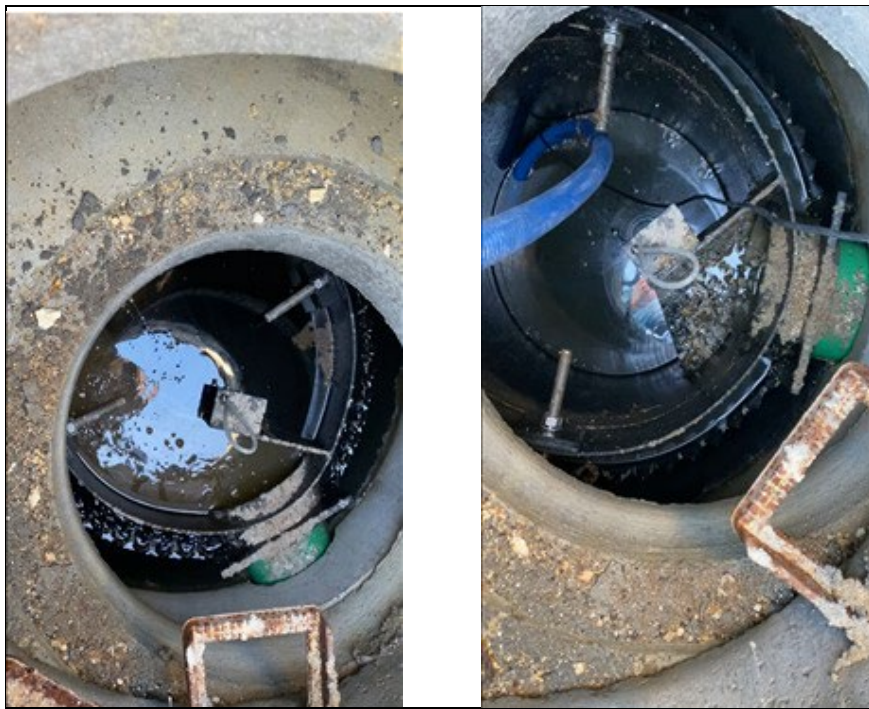
Bild 4-6: Hydraulische Prüfung (links); Absaugen des Schachtes (rechts)
