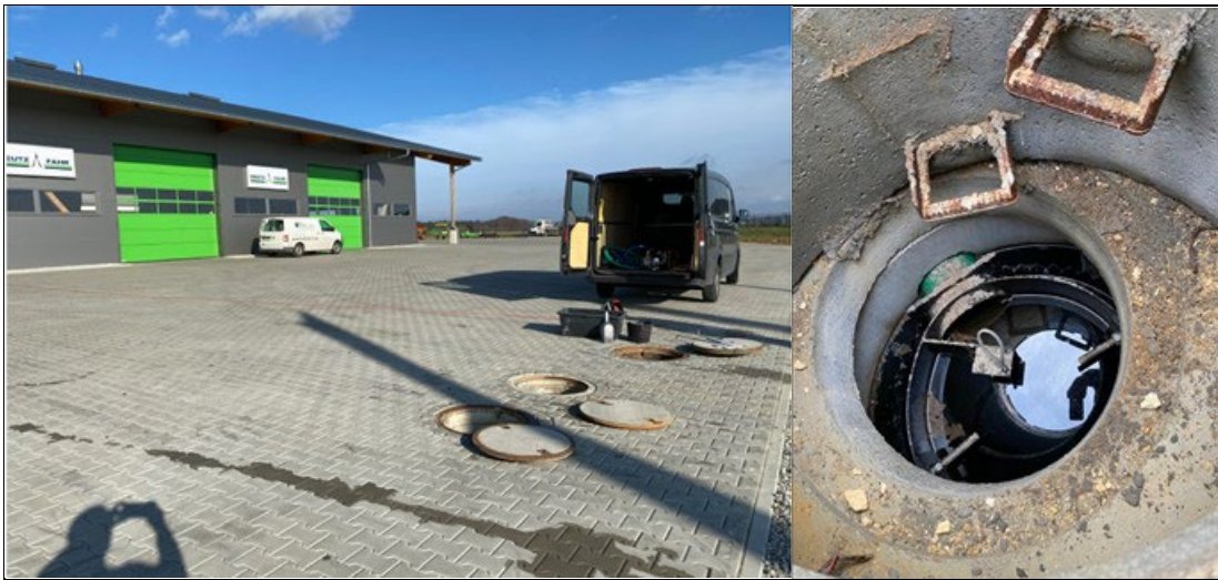
Bild 4-5: Schacht vor der Wartung (links); Blick in den Schacht mit eingebautem Hydroshark (rechts) (Beton- und Kiesreste vom Schachteinbau)
