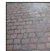
Pflaster mit Fugenverguss
