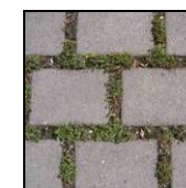
Pflaster mit Rasenfuge
