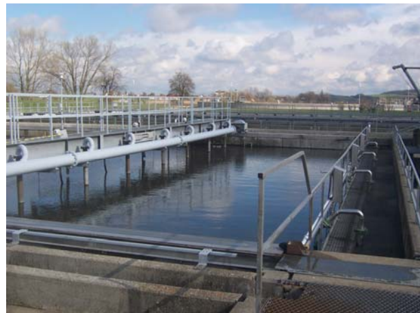
Endreinigung im Nachklärbecken
